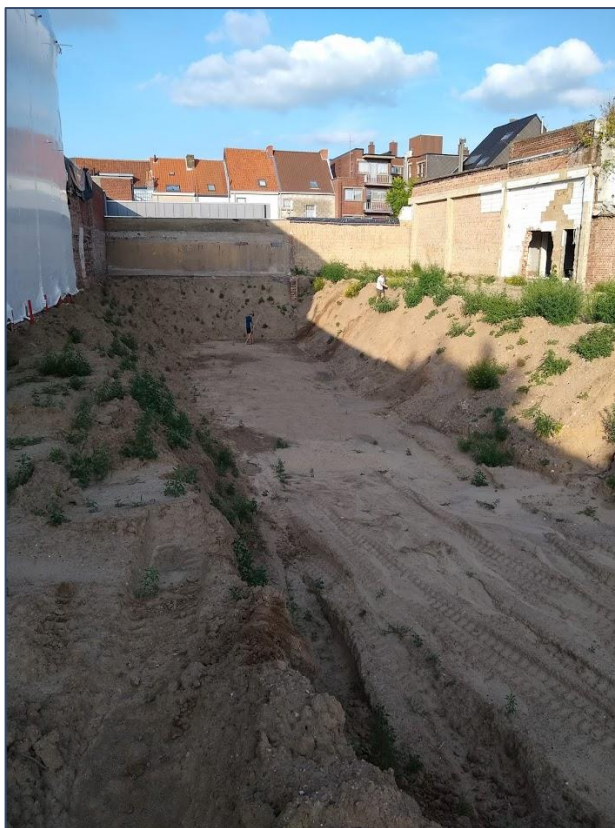
Figuur 3-2: bouwput van de uitgebroken kelder (zomer 2019).
