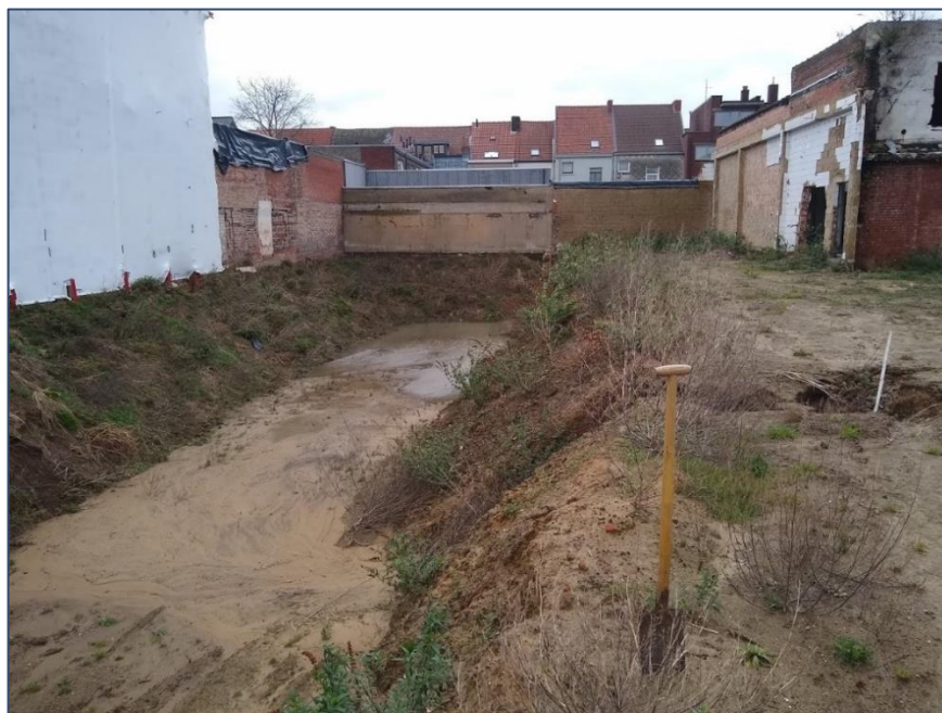
Figuur 3-3: bouwput van de uitgebroken kelder (februari 2020)
